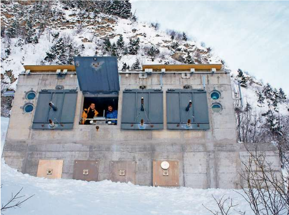
Mit einem Radar untersuchen Forschende vom Beobachtungsbunker aus das Fliessverhalten von Lawinen. Bild: zVg Yann Gross
