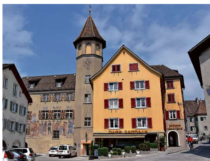
Im alten Rathaus in Maienfeld entstehen Unterrichtsräume und ein Atelier für die künftigen Studierenden der Schule für Gestaltung Graubünden. Bild Stefanie Studer
